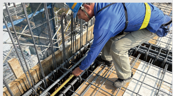
工程單位將金色樑柱安放入建築主結構中。
