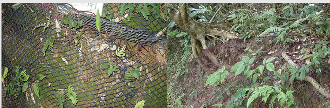
圖 9 廢漁網護坡初期 (左) 及約兩個月後 (右) 植物成長情形。
