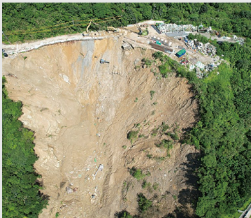
圖 6 發生在基隆槓子寮路的山坡崩塌。
