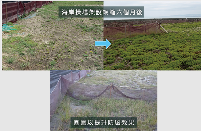
圖 4 在海岸以廢魚網架設防風籬六個月之後。
